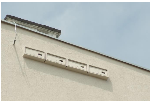
Fot. 16. Przykład montażu trocinobetonowych budek dla jerzyków w warstwie izolacyjnej.
