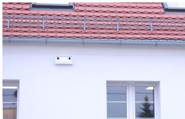
Fot. 20. Przykład montażu trocinobetonowej budki dla wróbli w warstwie izolacyjnej.
