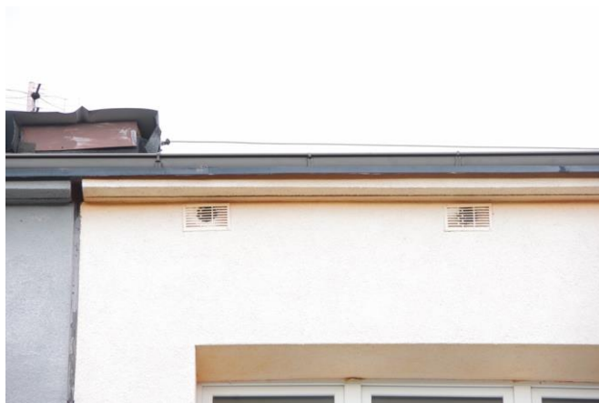
Fot. 22. Otwory wentylacyjne do stropodachu są zabezpieczone i niedostępne dla nietoperzy.
