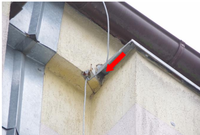
Fot. 6. Wlot do gniazda wróbli na północnej ścianie hali sportowej.
