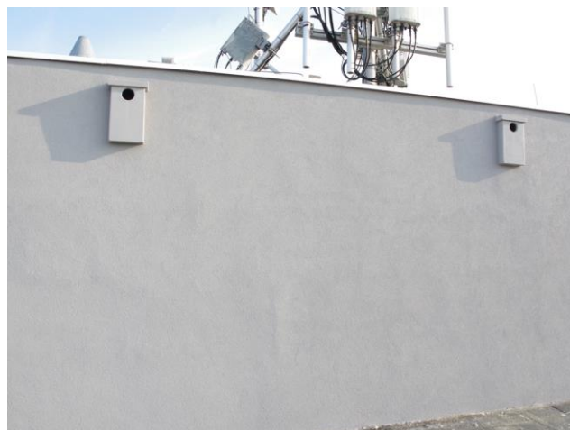
Fot. 18. Przykład montażu trocinobetonowych budek dla kawek w warstwie izolacyjnej.
